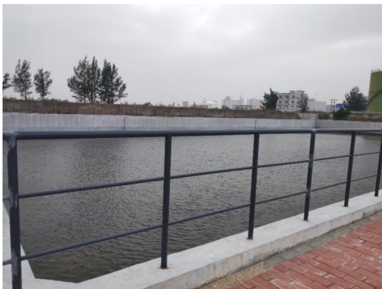
南迳湾库区事故应急池
