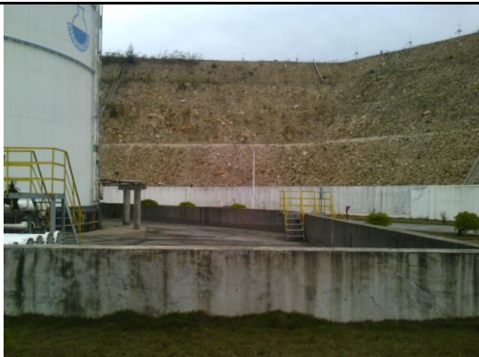
储罐区围堰
