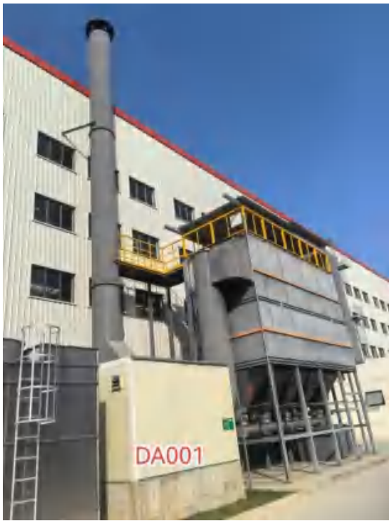
DA001 电熔炉、球化废气排气筒废气处理设施为旋风除尘器、布袋除尘器
